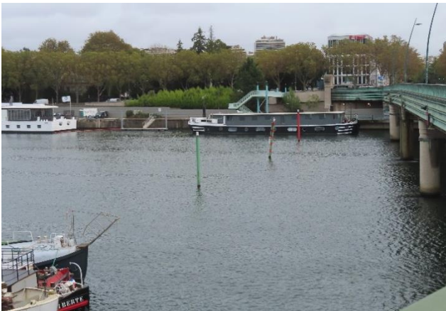
Un rapport paysager à l'ouvrage d'art à qualifier
