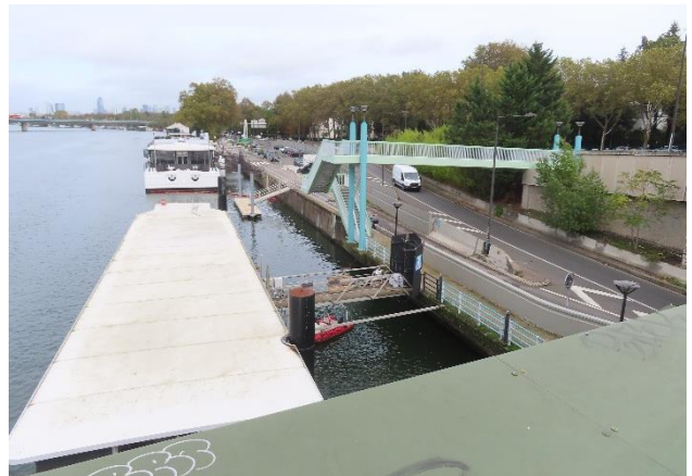
Vue du pont, la qualité du couvrement est un enjeu à cet emplacement
