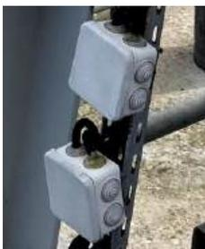
Certains boîtiers de raccordement électrique ont leur entrée de câble sur le dessus, ce qui n'est pas optimal concernant les potentielles entrées d'eau.
