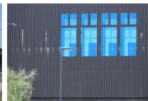
Exemple de traitement de façade d'entrepôts réalisé dans le cadre d'une réhabilitation - peinture sur tôle - Port de Saint Malo
