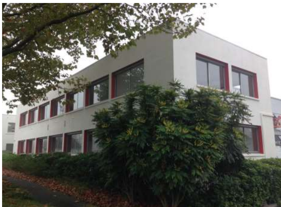
Bâtiment CC1 en cours de réhabilitation en 2017
