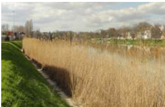
La berge de Marne renaturée par une roselière au pied du terminal conteneurs, Port de Bonneuil sur Marne
