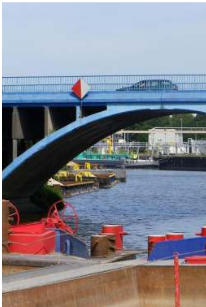
Le pont de la darse sud (route départementale) Port de Bonneuil sur Marne
