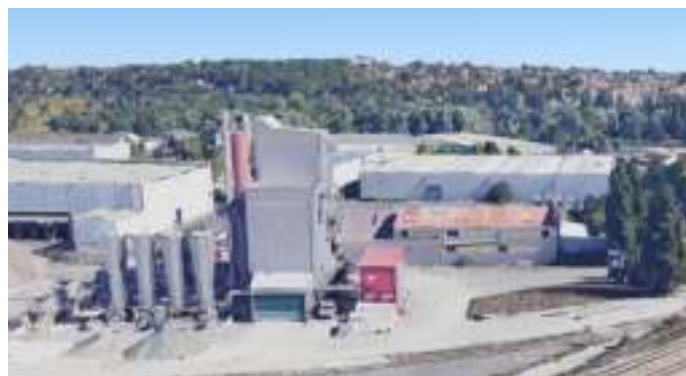
Tour de malaxeur Eiffage
