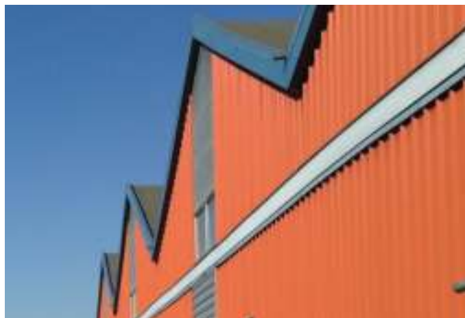
Les entrepôts du lot 7 Port de Bonneuil sur Marne
