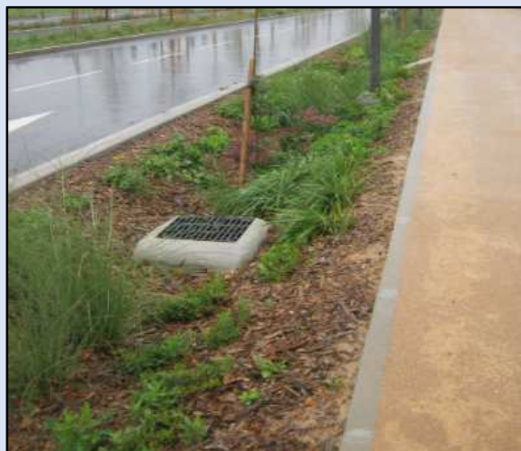
> Noue du Boulevard urbain Est, Vaulx-en-Velin (69) (Photo : SUEZ Consulting)
