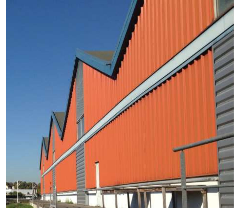
Les entrepôts du lot 7, Port de Bonneuil sur Marne
