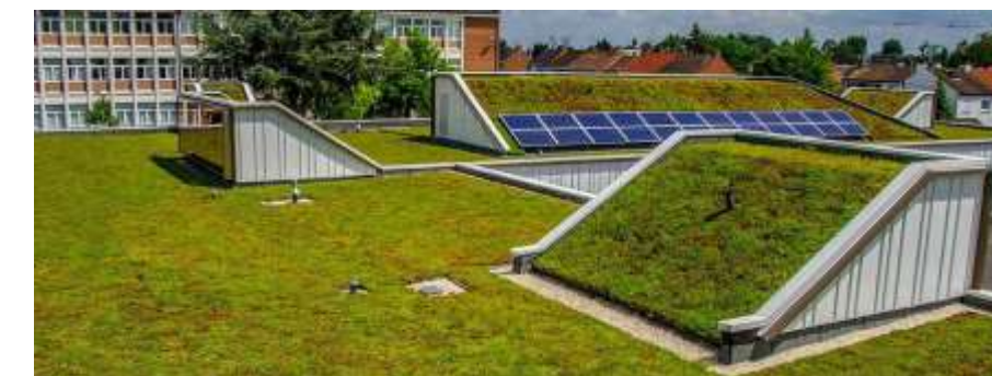
Toiture végétalisée associée à des panneaux photovoltaïques
