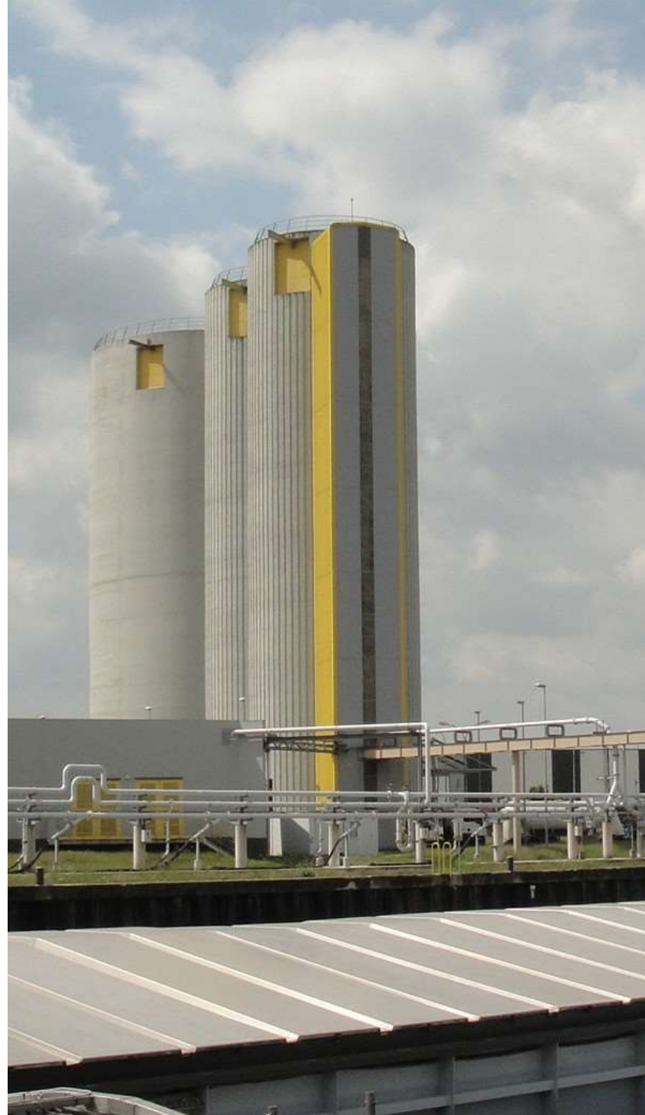
Les grands silos, Port de Bonneuil sur Marne
