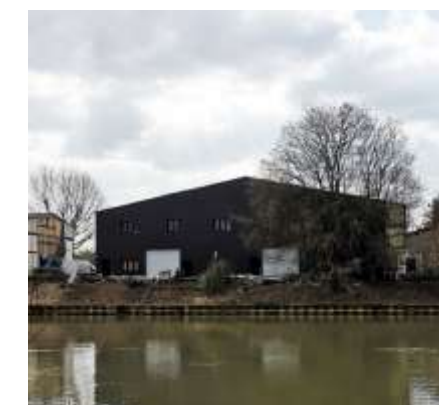
Façade déjà réhabilitée : Société Expo Sit
