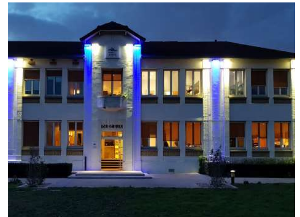
Mise en lumière des bureaux du port, Port de Bonneuil sur Marne
