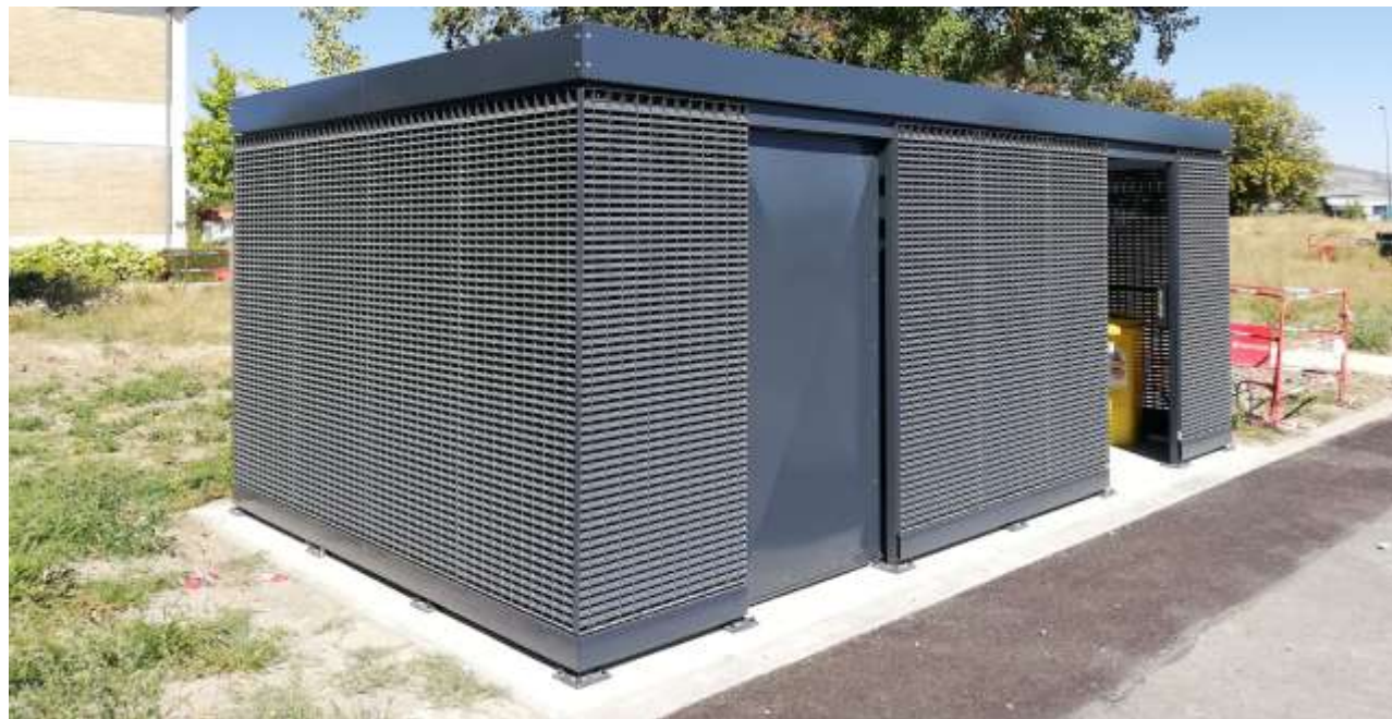
Locaux poubelles sur le port de Bonneuil
