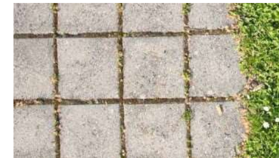
Pavés à joints drainants (gravier)
