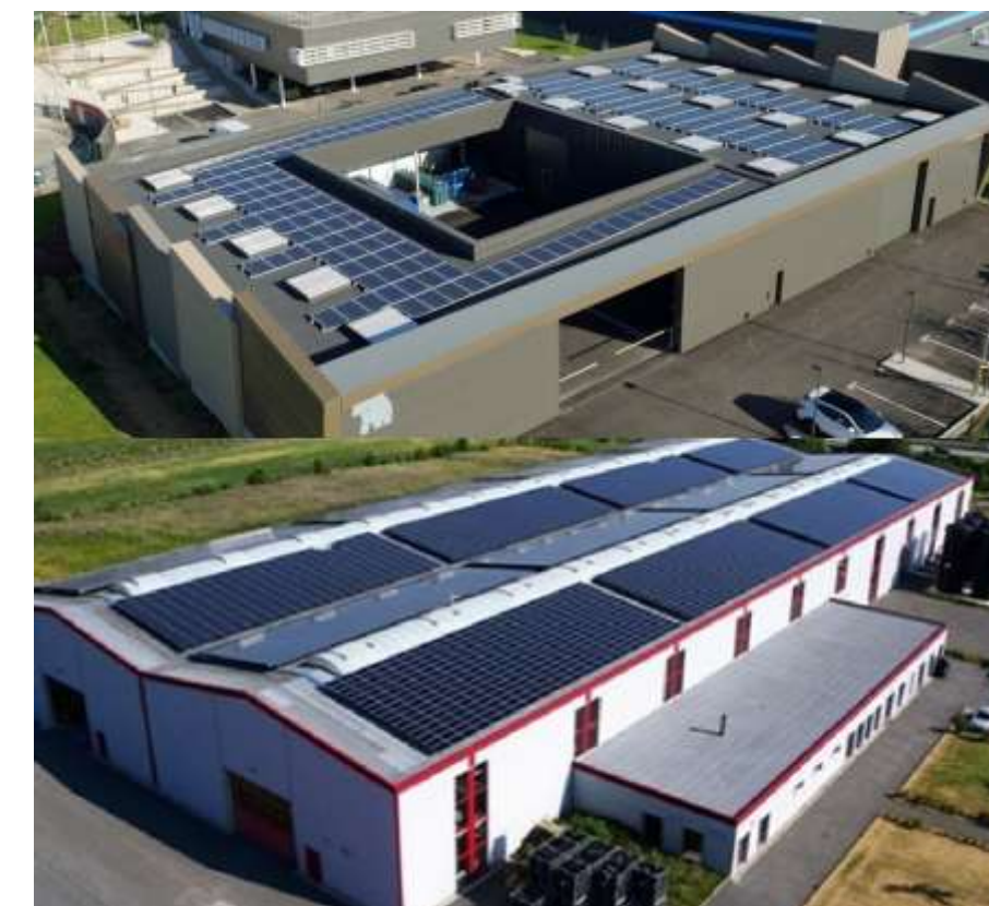
Installation de panneaux photovoltaïques en toiture de bâtiments industriels
