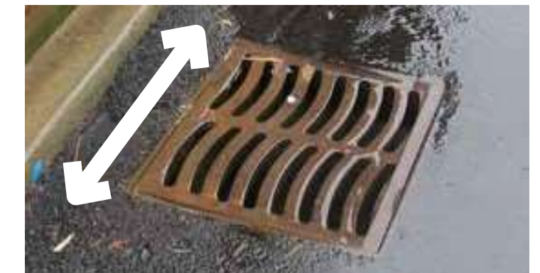
Grille d'égout avec des fentes inférieures à 2 cm et éloignée d'au moins 10 cm par rapport à un point dur afin de permettre le passage (flèche blanche) de la faune et d'éviter les chutes.
