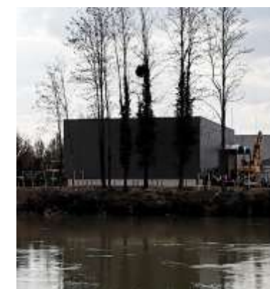
Façade déjà réhabilitée : Société DMS
