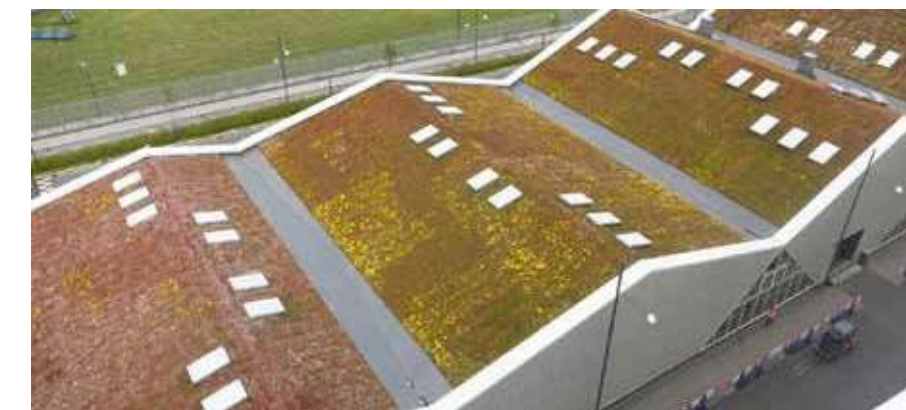
Toiture végétalisée d'un hangar à bateaux, Port de Copenhague - Malmö, Danemark
