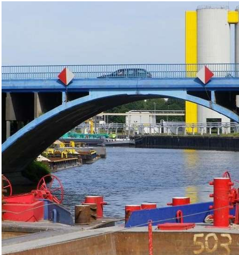
Le pont de la darse sud (route départementale), Port de Bonneuil sur Marne
