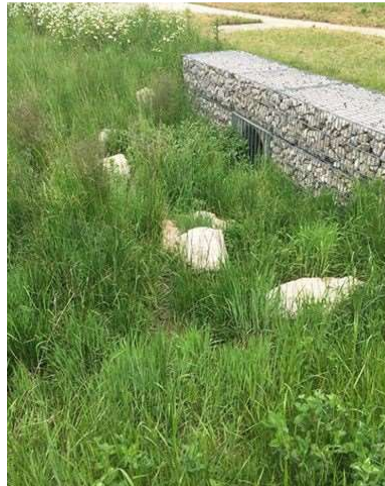
Exemples de gestion alternative des eaux pluviales
