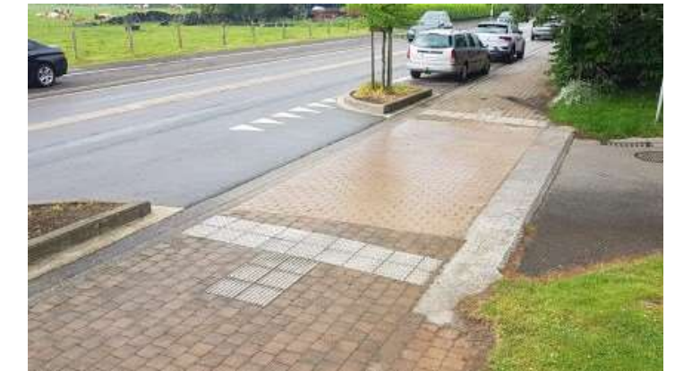
Trottoir traversant en zone résidentielle Changement de revêtement (couleur) marquant la traversée
