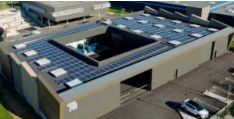
Toiture végétalisée associée à des panneaux photovoltaïques
