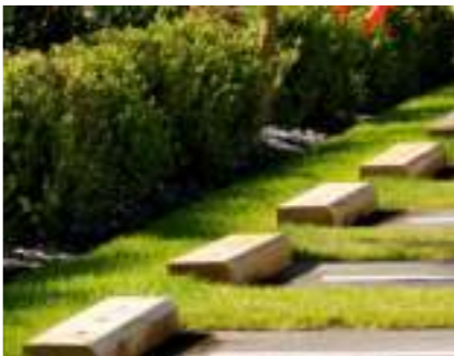
Exemple de butoirs pour protéger les clôtures des possibles chocs, permettre le passage de la petite faune ainsi que l'infiltration des eaux pluviales
