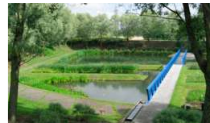
Ce qui est prescrit : Ouvrage végétalisé et pentes maximum de 2 pour 1
