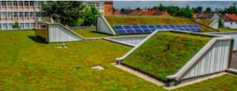
Toiture végétalisée associée à des panneaux photovoltaïques
