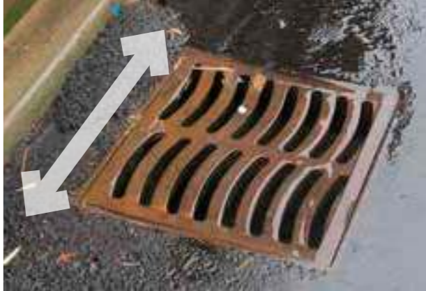
Grille d'égout avec des fentes inférieures à 2 cm et éloignée d'au moins 10 cm par rapport à un point dur afin de permettre le passage (flèche blanche) de la faune et d'éviter les chutes.
